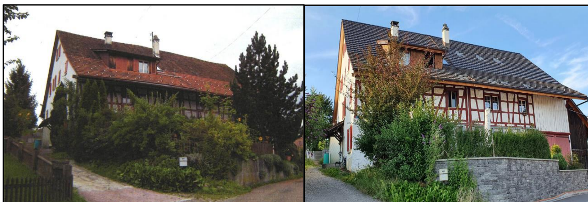
Slika 27: Streha pred sanacijo in po sanaciji pokrita s solarno opeko, Zürich. (Vir: Eitner, 2021).
