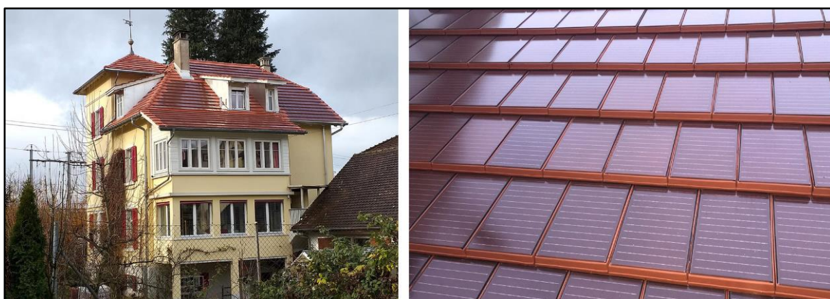
Slika 26: Fotovoltaični strešni sistem z rdečimi strešnimi moduli, Zürich. (Vir: Eitner, 2021).
